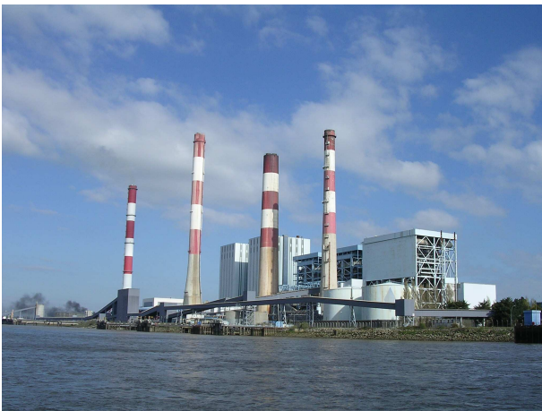
La centrale EDF de Cordemais
