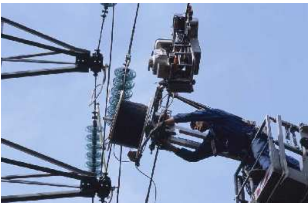
A partir de la nacelle, préparation de la pose du câble optique grâce au robot enrouleur de fibres optiques
